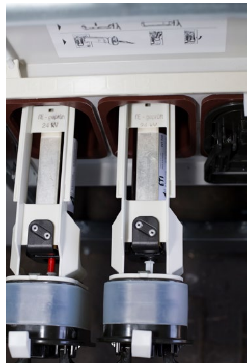
Vezivanje u unutrašnjem sklopnom (uklopnom) uređaju, primjer:
